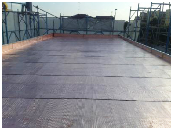
Impermeabilizzazione completata.
