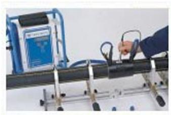
6. Una volta completato il ciclo di riscaldamento, gli indicatori di fusione dovrebbero essere saliti.
